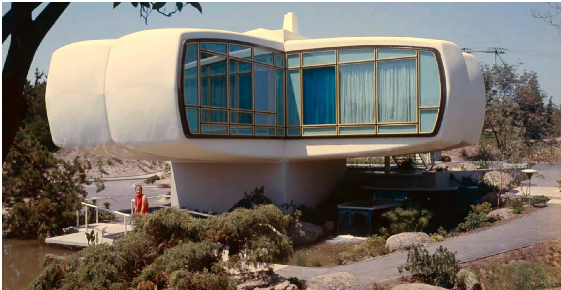
Foto: Future House a Disneyworlds, any 1957.
